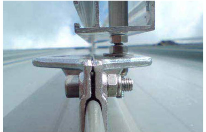
Kuva 22. Konesauma- ja lukkoponttipeltikatteelle sopiva kiinnike.
