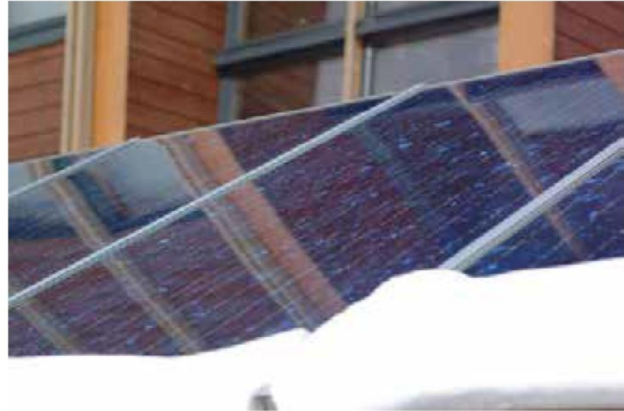
Kuva 32. Aurinkopaneelin tuotto heikkenee oleellisesti sydäntalvella, eikä sitä yleensä kannata puhdistaa lumesta. Kevätaurinko sulattaa lumen tummalta pinnalta.
