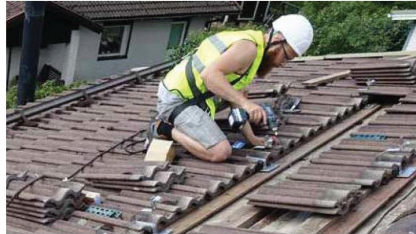
Kuva 16. Paneelit kestävät jopa yli 30 vuotta. Jos rakennuksen vesikatteen odotettu käyttöikä on huomattavasti lyhyempi, kannattaa harkita katteen ja tarvittaessa rakenteiden uusimista aurinkosähköjärjestelmän asennuksen yhteydessä.
