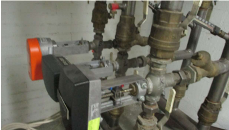
Kaukolämpöpaketin moottorisäätöventtiilejä.
