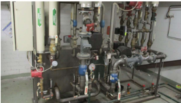
Kaukolämpöpaketti lämmönjakohuoneessa.
