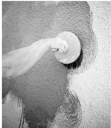
Kuva 3. Kalkkimaalaus tehdään aina luonnonjousisella kalkkihakkurilla pyörittävin liikkein.
