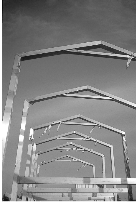
Kuva 3. Asuinrakennuksen ruostumaton teräsrunko. Lähde: Stelos Oy.
