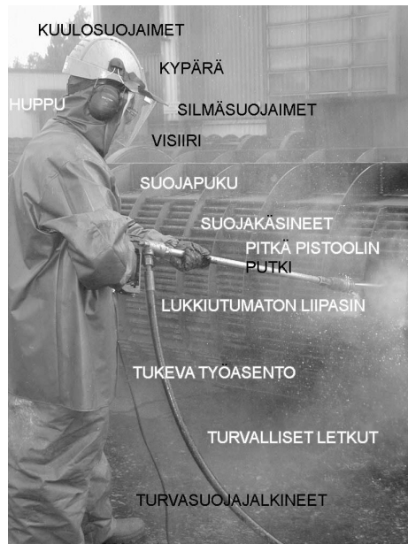
Kuva 1. Painevesitöiden turvallisuuteen vaikuttavat useat tekijät.
