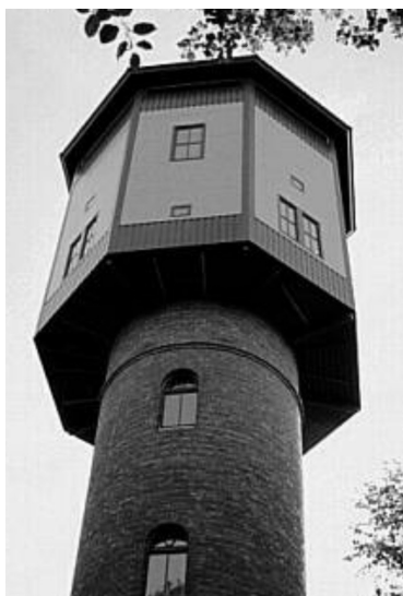
Kuva 2. Sandwich-elementeillä voidaan verhoilla monimutkaisia ja moni-ilmeisiä julkisivuja, a) urheiluhallin ja b) näköalatornin julkisivu.
