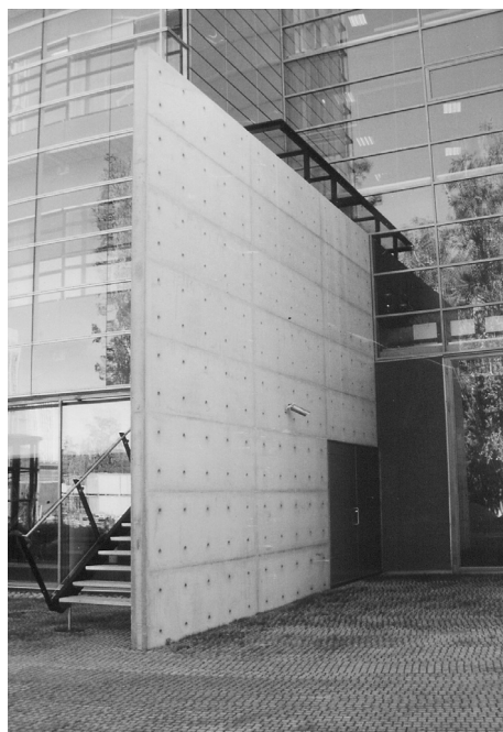
Kuva 17. Itsetiivistyvällä betonilla kertavaluna valettu paikallavaluseinä.
