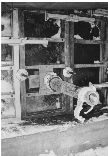
Kuva 16. Muottipinnan lävitse tapahtuvaan betonin pumppaukseen tarkoitettua kalustoa.
