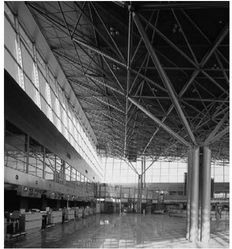
Kuva 1. Palosuojamaalauksella voidaan suojata monimuotoisia rakenteita esteettisyyden karsimättä. Kuvassa vain pilarien ja avaruusristikoiden väliset rakenneputket ovat palosuojamaalattuja.
