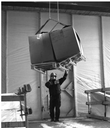
Kuva 3. Logistiikasta vastuullinen henkilö vastaanottamassa torninosturin nostoa valoaukon väliaikaiselle nostotasolle. Kuva: Projektin arkisto/J.Keppo
