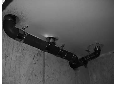
Kuva 4. Käytetty tapa on asentaa putket alemman kylpyhuoneen laskettuun alakattoon.
