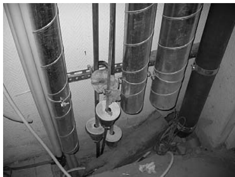
Kuva 3. Uusi putkihormi uudessa paikasta. Huom. vuotovesikupit.
