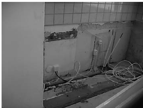
Kuva 2. Keittiö purkutöiden jälkeen.
