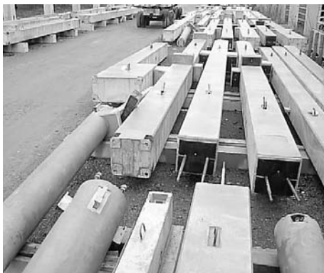
Kuva 1. Betonielementit tuetaan ja kiinnitetään työmaalla toisiinsa vakioliitoksien.
