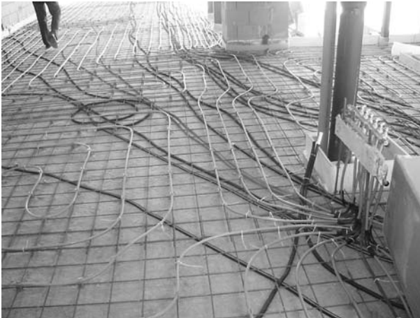
Kuva 4. Vesikiertoinen lattialämmitys asennettuna ennen valua.
