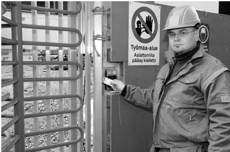
Henkilötunniste 3. Vuosaaren Cirruksen työmaalla oli käytössä Rakennusteollisuus RT:n kehittämä sähköinen kulkulupajärjestelmä Elku.
