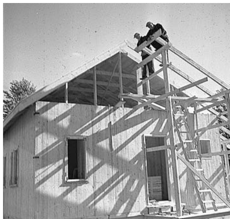
Kuva 22. Alvar Aalto: A. Ahlström Oy:n Varhaisen talon talotehtaan esivalmistaman tyyppitalon pystytys 1940.
