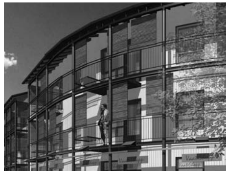
Kuva 4. Jäähdytystarve on huomattavasti vähäisempää, kun käytetään pienempiä ikkunoita ja varjostavia parvekkeita tai ritilöitä.
