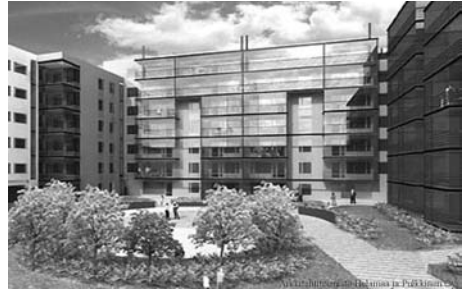
Kuva 3. Kun lasitus kattaa lähes koko julkisivun, lämpö-olojen hallinta edellyttää auringonsuojalasin ja jäähdytyksen käyttämistä.
