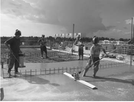
Kuva 3. Holvin betonointia laavabetonilla ja uusilla työkaluilla.
