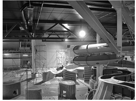
Kuva 2. Flamingon rakennusteknisesti vaativimpia töitä olivat yli hehtaarin kokoisen allasosaston vesitiiviit paikallavalubetonirakenteet, jotka toteutettiin ilman erillistä vedeneristettä jälkijännityksen, saumanauhojen, ja injektointiletujen avulla.
