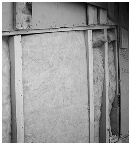
Kuva 2. Jos tekijällä on aikaa kiertää eriste saadakseen se jäämään liian leveään väliin, luulisi hänellä yhtä hyvin olevan aikaa tehdä työ kunolla.
