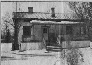
Den Alborgska villan hör till de objekt som Länsstyrelsen i Malmö vill skydda. Foto: Bengt Rönqvist.
