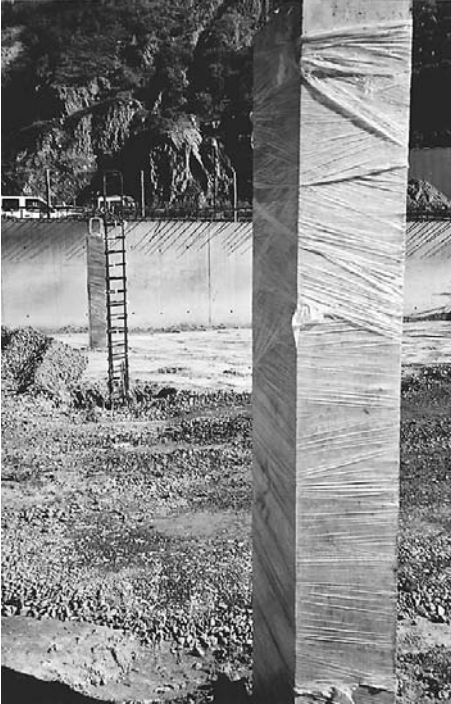
Kuva 7. Betonipilaria jälkihoidetaan muovikelmulla muotinpurun jälkeen Kapkaupungissa Etelä-Afrikassa.
