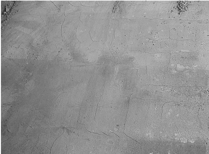
Kuva 6. Epäonnistunut varhaisjälkihoito aiheuttaa lattiapintaan vaurioita. Kuvan lattia valettiin hyvälaatuisella betonilla kesällä. Tuoreen, notkean/plastisen betonilattian pinta on tuulisuuden ja auringonpaisteen vuoksi päässyt kuivumaan liikaa, joten tuoreen/plastisen betonin pintaan on syntynyt ruutu/verkkomaista halkeilua. Kuvassa esitettyjen halkeamien väliset etäisyydet vaihtelevat pääsääntöisesti välillä 10–20 cm. Yläreunassa näkyy yksittäisiä noin 16 mm:n suuruisia runkoainerakeita.
