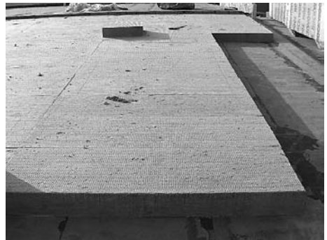
Pohjalämmöneristeen asennus.
