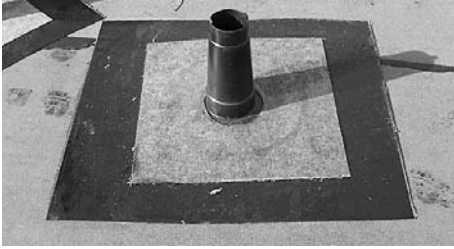
Tuuletusputken asennus laipan kanssa pohjahuopaan.
