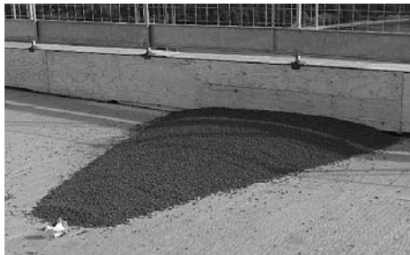
Vesikaato rakentuu leca-soralla, ei tuulettuva räystääs.
