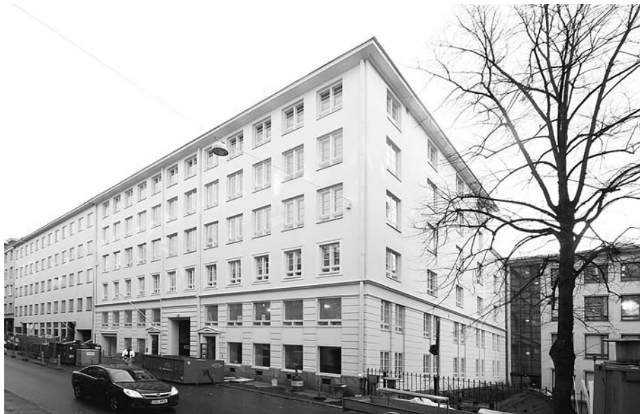
Asuntojen ääneneristys Lönnrotinkadun puolella on varmistettu desibeli-ikkunoilla. Kuva Arto Rautiainen/Skanska Oy.
