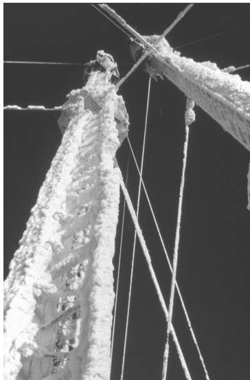
Kuva 1. Huurrejäättä ristikkorakenteisissa mastoissa Yllästunturilla.
