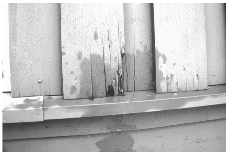
Kuva 2. Home ja sinistymä kehittyvät kun ympäristön ilman kosteus on riittävä ja puuhun kehittyy värivikaa (vasemmalla). Laho kehittyi, kun puurakenteeseen kertyy vettä, jolloin myös puun lujuus heikkenee (oikealla).
