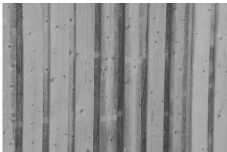
Kuva 2. Home ja sinistymä kehittyvät kun ympäristön ilman kosteus on riittävä ja puuhun kehittyy värivikaa (vasemmalla). Laho kehittyi, kun puurakenteeseen kertyy vettä, jolloin myös puun lujuus heikkenee (oikealla).
