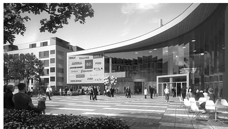
Kuva 2. Kauppakeskuksen sisäänkäynti Tulliaukiolta.
