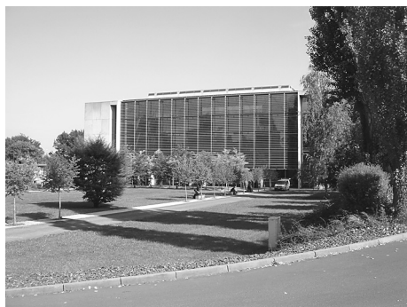
Kuva 4. Erilaisilla varjostusratkaisuilla voidaan vähentää rakennusten jäähdytystarvetta. Kuvan rakennuksessa on auringon lämmittävää vaikutusta vähentävät säädettävät säleiköt ikkunoiden edessä.
