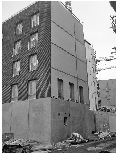
Kuva 8. Paksurappaus-eriste-elementit asennettuna rakennuksen päätyseinään.
