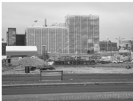
Kuva 2. Esimerkki rakennustyömaan sääsuojauksesta Ruotsin Malmössä. Kerrostalo rakennetaan kokonaan sääsuojaossa. Tosin lämmöneristeiden varastoinnissa suojaustaso ei ole samalla tasolla, vaan ne ovat paljaan taivaan alla.
