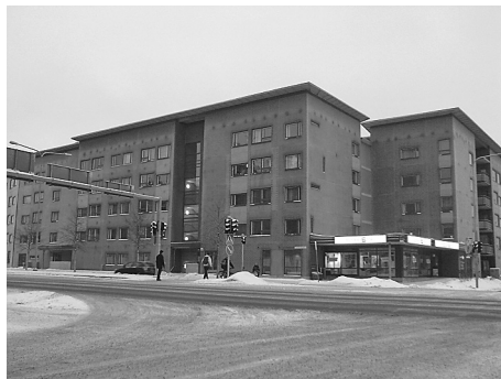
Kuva 1. Lämmöneristyskyvyn parantuessa seinän ulko-osat altistuvat nykyistä ankarammalle pakkasrasitukselle lämpövuotojen vähentyessä. Kuvassa ulkoseinän kylmäsillat erottuvat selvästi muuten huurtuneesta julkisivusta.
