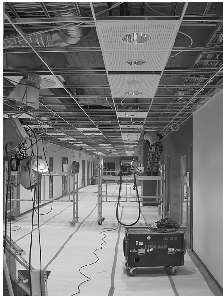
Kuva 5. Toimintakoevaiheen siivous on aloitettu alakaton yläpuolisilla pinnoilla ja jatkuu alemmille pinnoille pölyn poistamiseksi toimintakoeputausta varten.
