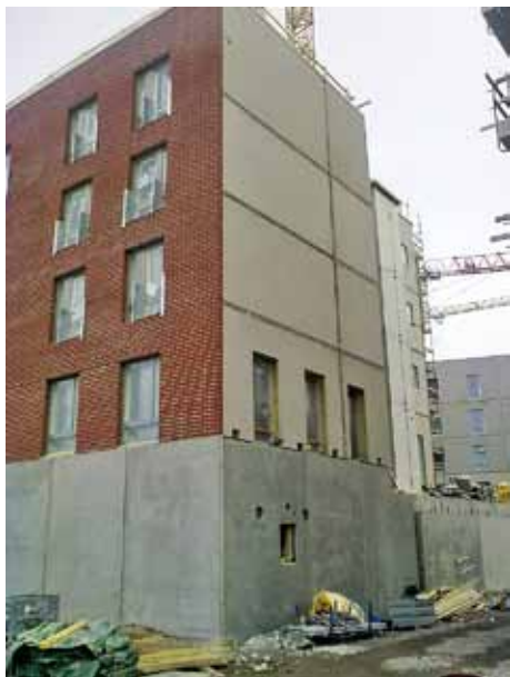
Kuva 4. Paksurappauseriste-elementit asennettuina rakennuksen päätyseinään.
