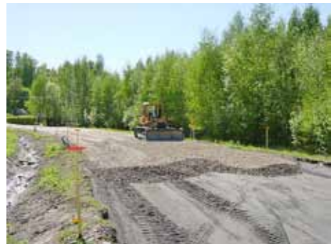
Kuva 6. Betonimurskeen käyttöä tienrakentamisessa.
