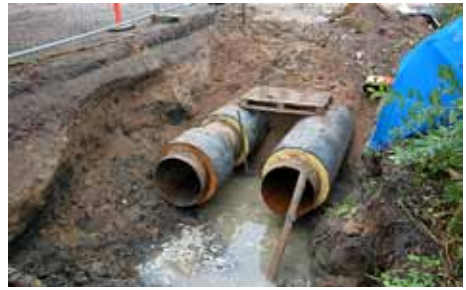
Kuva 1. Kaukolämpötyömaalla hitsaaja oli makuuasennossa noin metrin syvyisessä kaivannossa hitsaamassa kaukolämpöputkeen jatkoa, kun maa sortui hänen päälleen, katso TOT 17/06. Kuvassa sortuman kohta on putken vieressä vasemmalla.
