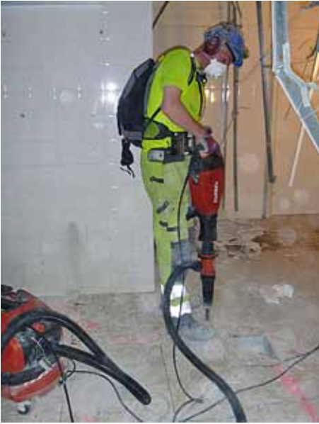
Kuva 6. Kaakeleiden poisto (piikkausvasarassa kohdepoisto): hengittyvä pöly 10–14 mg/m 3 , alveolijakeinen kvartsi 0,013 mg/m 3 (ilman kohdepoistoa pölypitoisuudet 4–6-kertaisia ja kvartsipitoisuudet n. 10-kertaisia).
