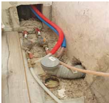
Kuva 1. Vaarallisia vesijohtoasennuksia.
