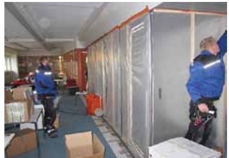
Kuva 4. Suljettu ja alipaineistettu purkutila.
