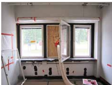
Kuva 3. Ulkoseinärakenteen ja alapohjarakenteen tiivistyskorjauksia.
