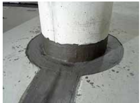
Kuvat 5 ja 6. Alapohjarakenteen tiivistyskorjauksia ennen pintarakenteiden asentamista.
