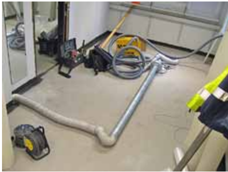
Kuvat 5 ja 6. Esimerkit rakenteiden koalipaineistuksesta.
