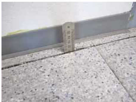
Kuvat 1 ja 2. Tyypillisiä vuotoilmavirtareittejä, joiden kautta esimerkiksi maaperässä olevia epäpuhtauksia voi kulkeutua sisäilmaan.
