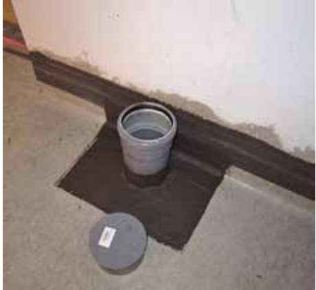
Kuvat 7 ja 8. Esimerkit maanvaraisen alapohjarakenteen alipaineistuksen läpivientikappaleista.
