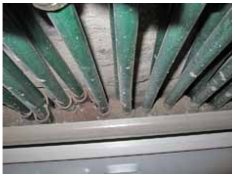
Kuvat 1 ja 2. Tyypillisiä vuotoilmavirtareittejä, joiden kautta esimerkiksi maaperässä olevia epäpuhtauksia voi kulkeutua sisäilmaan.
