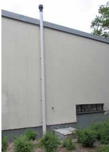
Kuvat 9 ja 10. Esimerkit alipaineistusjärjestelmän poistoputkien sijainneista.
