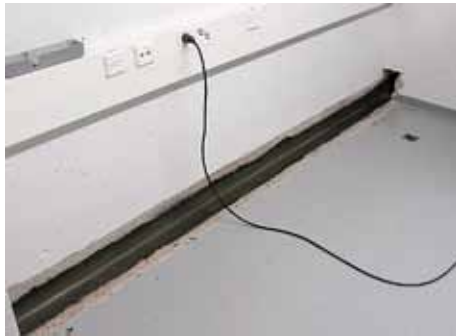
Kuva 16. Tyypillinen alapohjarakenteen ja kantavan seinän liittymäkohdan tiivistyskorjaus.
