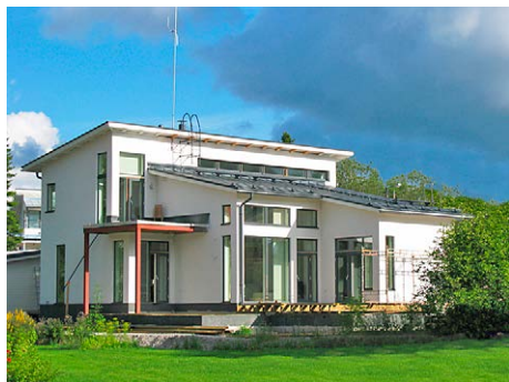
Kuva 2. Nykyaikaisen pientalon rakentaminen edellyttää monenlaista ammattitaitoa. Tarvittavia ammattilaisia ovat mm. rakennus-, LVI-, sähkösuunnittelijat sekä vastaava työnjohtaja.
