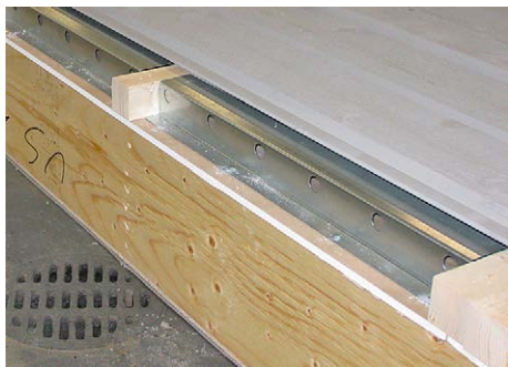
Kuva 3. Julkisivun palokatko. (Kuva: Puuinfo).
