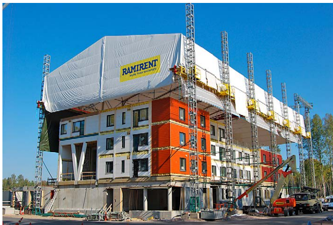
Kuva 8. Rakennusliike Reponen rakensi Vantaan Kivistöön Euroopan suurinta puukerrostaloa teltan alla säältä suojassa. Säältä suojassa rakentaminen mahdollistaa rakennusajan puolittamisen. (Kuva: RKL Reponen, Tiia Sorsa).
