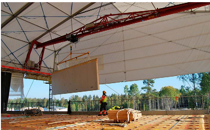
Kuva 9. Teltan alla on lähes teollisuustilaa vastaavat työolot. Teltan alla sijaitseva siltanosturi toimii samalla periaatteella kuin teollisuushallissa. Seinäelementit kohteeseen on toimittanut Koskisen Oy ja välipohjaelementit VVR-Wood Oy. (Kuva: RKL Reponen, Tiia Sorsa).
