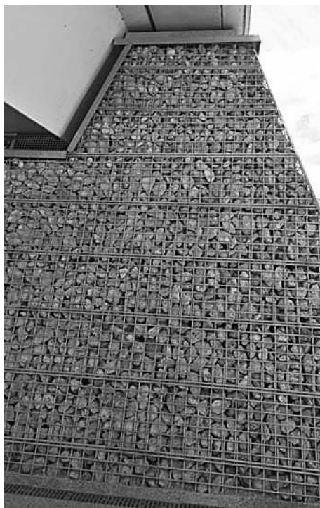
Kuva 4. Kierrätysbetonin käyttöä ympäristörakentamisessa Lontoon olympiapaistossa.
