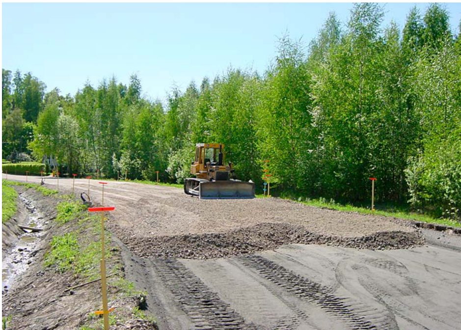
Kuva 3. Betonimurskeen käyttöä maarakennuksessa.
