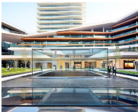
Kuva 2. Rakennesuunnittelijoiden palkitsema lasirakennerratkaisu Istanbulin Zorlu Lantern -rakennuksessa Turkissa. Neljästä isosta lasista tehdyt seinät toimivat kantavina elementteinä ja liittyvät saumattomasti muihin materiaaleihin edustaen aikamme lasirakennusteknologian ehdotonta kärkeä. (Lähde: James O'Callaghan, www.gpd.fi , Eckersley O'Callaghan).
