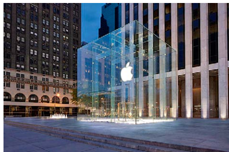
Kuva 1. Laselementit on yhdistetty kuutioksi Applen Manhattanin myymälässä New Yorkissa Yhdysval- loissa. Toteutus yhdistää tilaajan yritysimageon liitty- vät tavoitteet edistyneen lasirakentamisen ja suurten lasikokojen tuomiin mahdollisuuksiin. (Lähde: James O'Callaghan, www.gpd.fi , Eckersley O'Callaghan).
