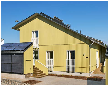
Kuva 6. Tampereen Asuntomessuilla esiteltiin vuonna 2012 lähes nettonollaenergiatalo Lantti, jossa tarvittava energia saadaan aurinkopaneeleista ja -keräimistä sekä kaukolämmöstä.
